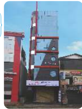
Painuthura Towers, Cochin. Actual project
