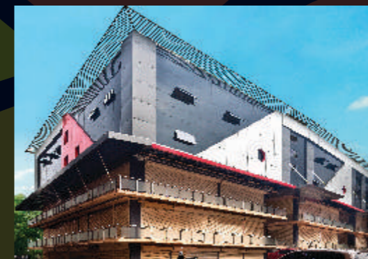
Yamuna Arcade, Calicut. Actual Project
